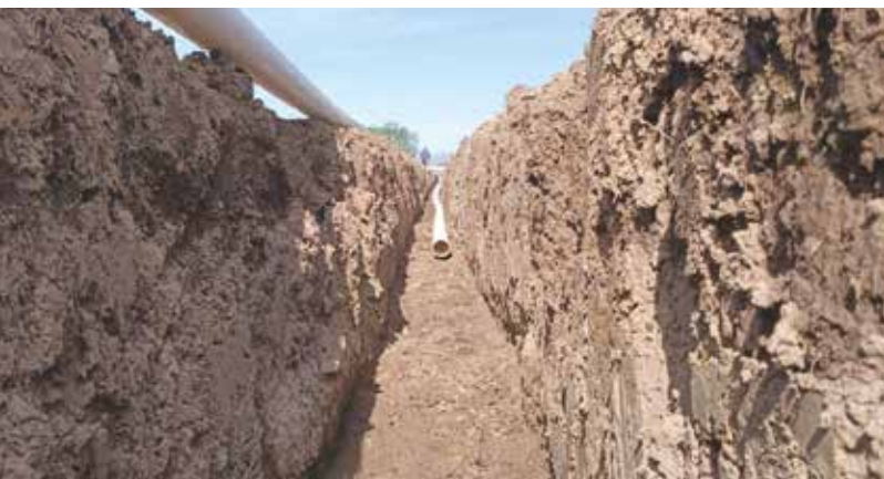
Zanja de una red hidráulica en El Sauz.
