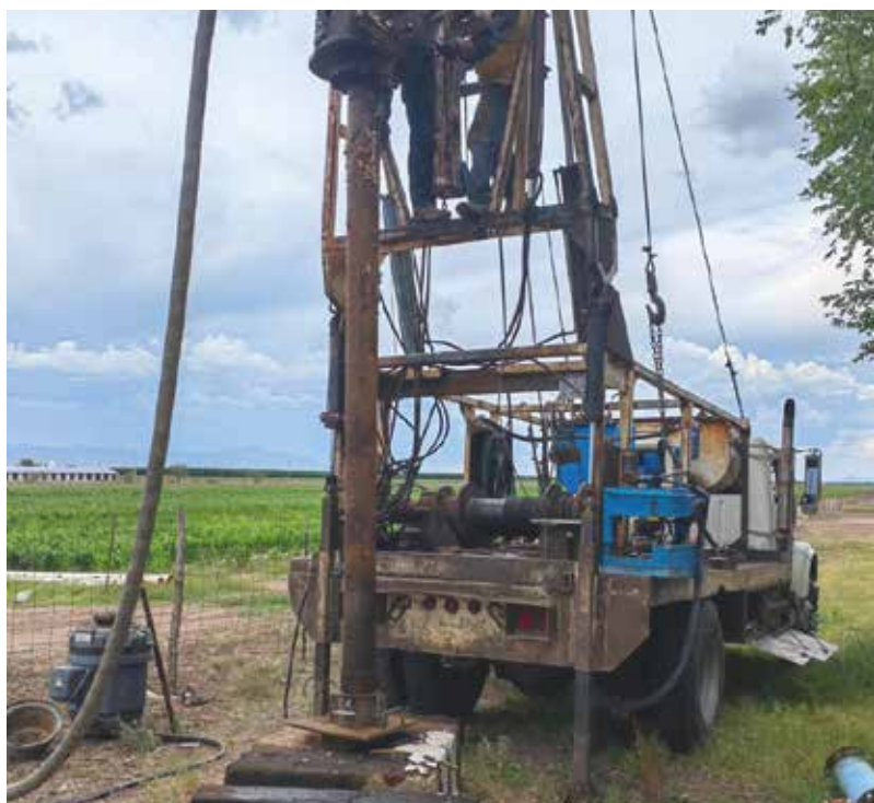
Perforadora de un pozo agrícola en El Sauz.
