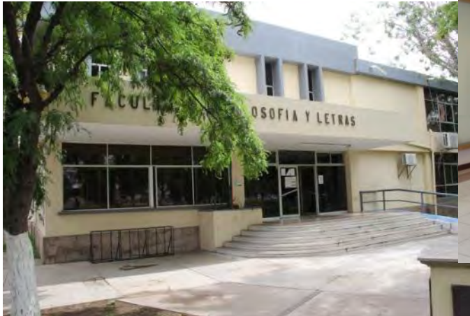
Entrada principal de la Facultad de Filosofía y Letras. Edificio A.
